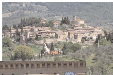
Recupero del borgo di Montefioralle. Intervento finanziato con contributi privati
